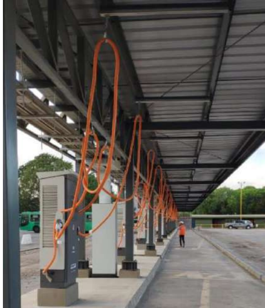
Figura 28: Techo en un electroterminal (Fuente: Elaboración propia)
